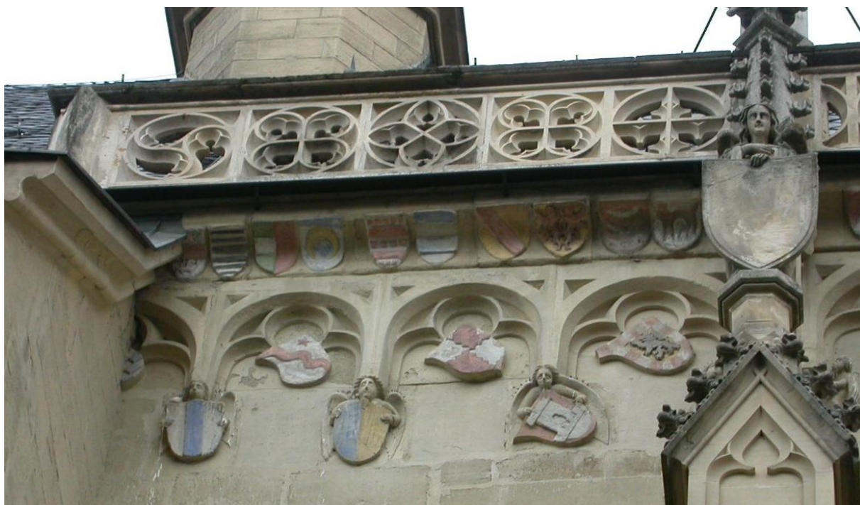
Abb. 1: Pfeiler 1 des Chors der Ritterkapelle Haßfurt. Deutlich ist in der obersten (ersten) Reihe links das halb verdeckte Wappen der Schenk von Stauffenberg zu sehen. In der mittleren (zweiten) Reihe links erkennt man noch den unteren Teil des Wappens der Herren von Dachenhausen. Das Wappen der Herren von Schlieffen, das in der obersten (ersten) Reihe links das erste Wappen sein müsste, ist wegen des 1889–1890 verbreiterten Pfeilers nicht mehr zu erkennen. (Foto: Wolfgang Jäger, 2004)
